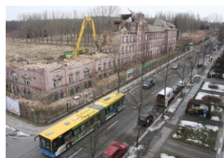
Abriss der Kasernengebäuden 2012
