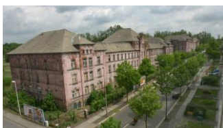
Heinrich – Schütz – Straße mit Kasernengebäuden um 2010
