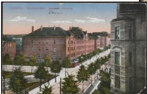
Planitzstraße mit Kasernengebäuden um 1910
